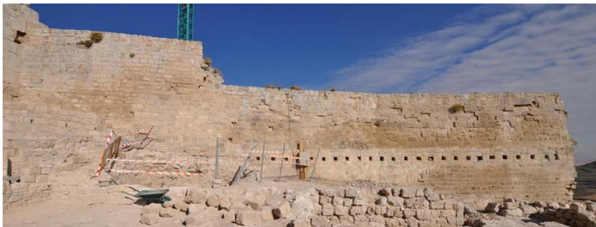
Por último, en el sector SO del patio, se construye otro aljibe de gran capacidad, con paredes de sillares revestidos de un potente mortero hidrófugo y cubierta abovedada. Las esquinas se rematan en chaflán y tanto la base como el rodapié están enlosados con piezas de ladrillo macizo. Se trata del segundo aljibe del castillo, posterior al otro que tiene acceso desde la torre del homenaje.
