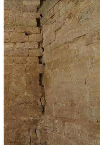
Detalle del tapiado (en el siglo XVII) y del sistema constructivo: imbricaciones irregulares y escalonado de pisos
