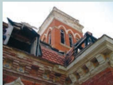
Detalle del deterioro de las molduras, cornisa, ventana, escamas y tejas planas del nivel de buhardilla como consecuencia de la obturación del canalón perimetral.
