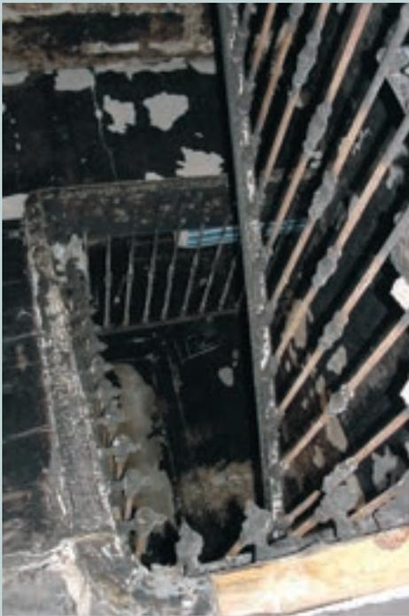
El incendio de 1998 tuvo su foco en la planta baja y el fuego ascendió por la escalera, que quedó completamente carbonizada. Sin embargo, su estructura de tres zancas ha podido conservarse.
